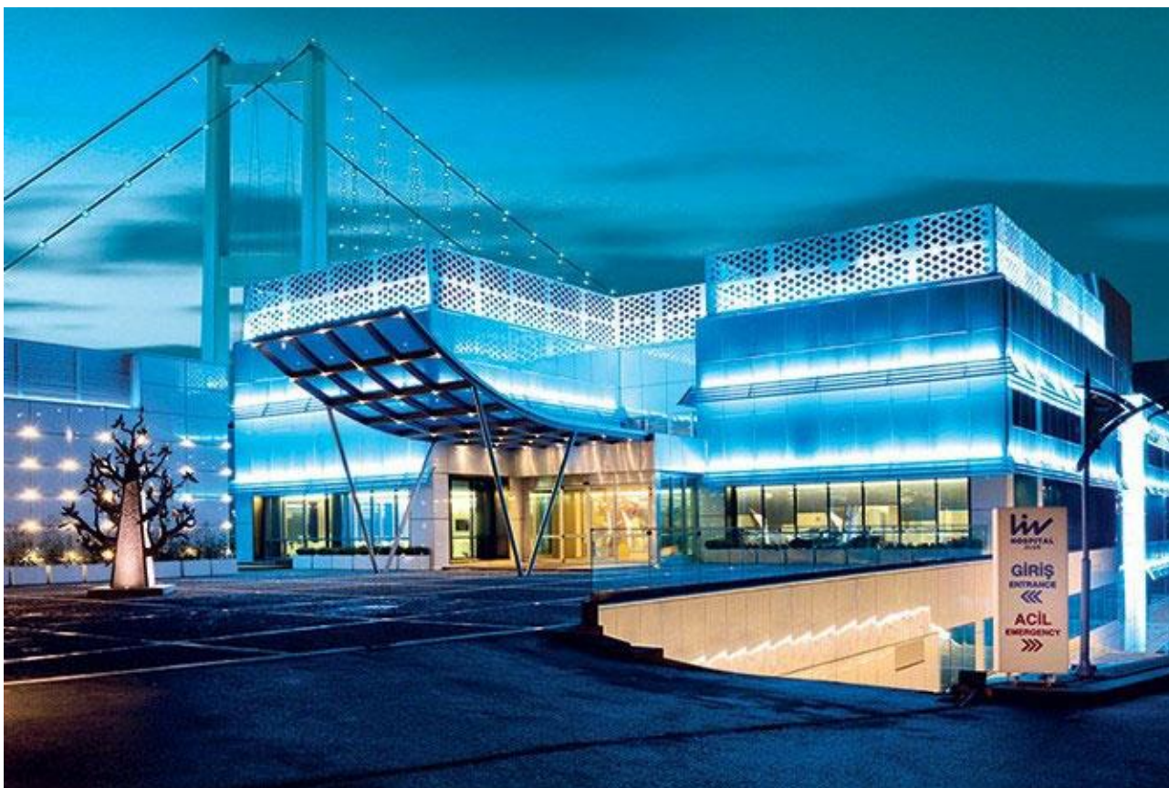
Рис. 2.7. Об'єм фасадів з освітленням
