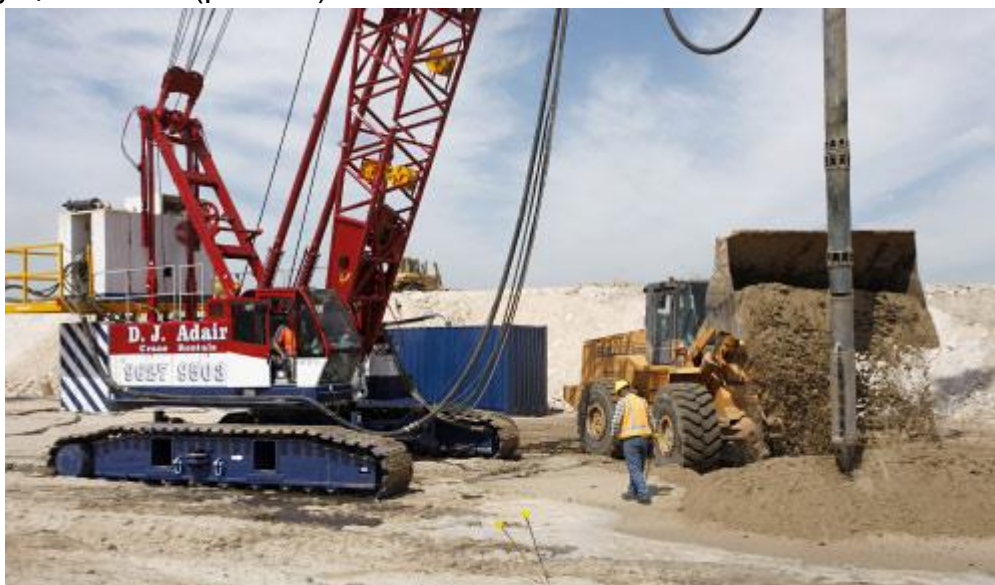
Рис. 73. Схема засипання кратера ґрунтом з повторним віброущільненням віброфлотатором
