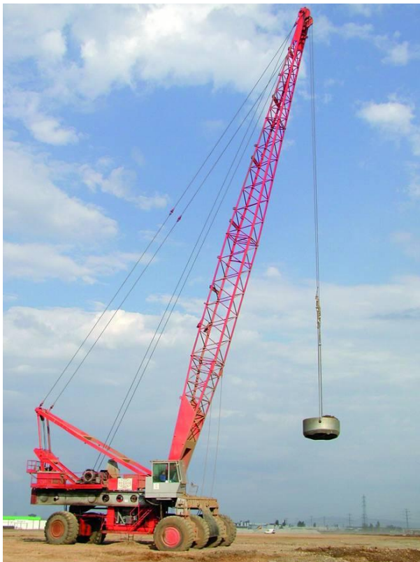
Рис. 74. Динамічне ущільнення ґрунту з використанням трамбівки 25 т з висоти 28 м
