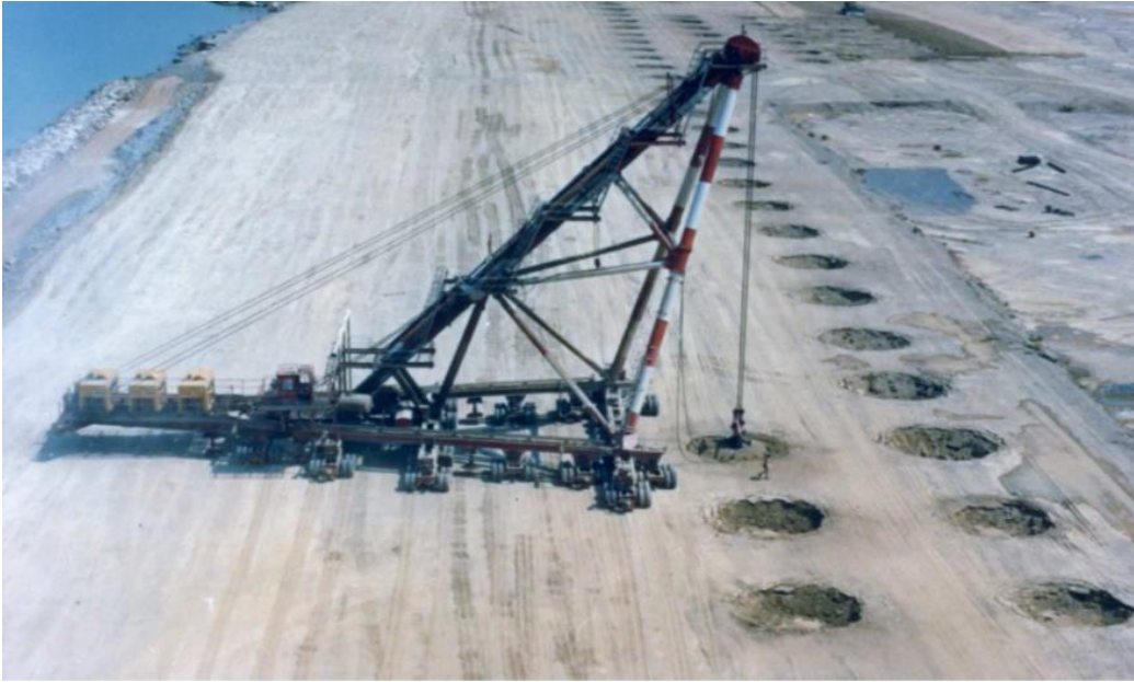
Рис. 75. Динамічне ущільнення ґрунту гігамашиною
