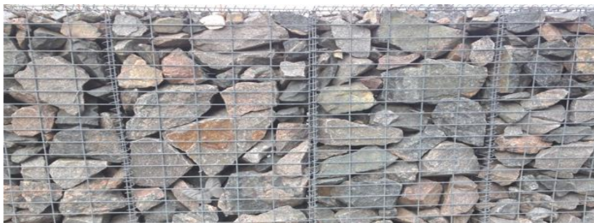
Рис. 17. Габіон: a – загальний вид; б – дротяна чарунка габіона; в – габіон зі зварної сітки, заповнений гранітним камінням
