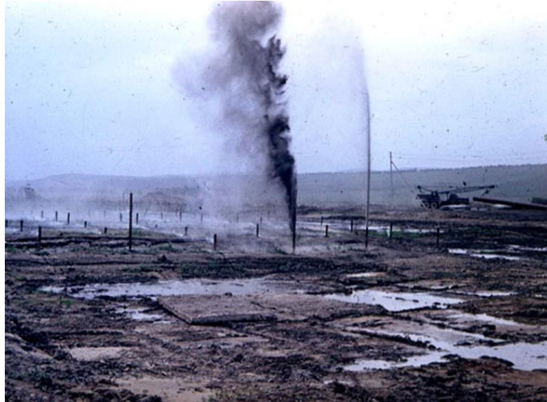
Рис. 82. Ущільнення лесового ґрунту гідровибухом
