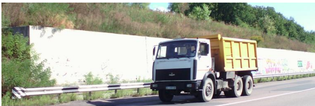
Рис. 28. Масивна підпірна стіна споруджена після зсуву ґрунту на автомобільну дорогу
