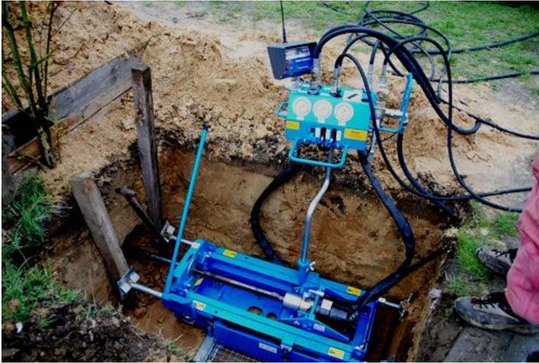
Рис. 10. Шахтова бурова установка в роботі
