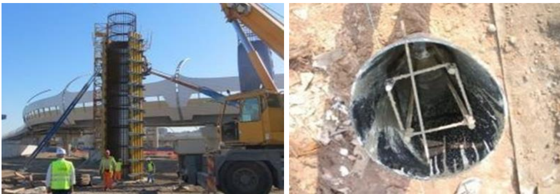
Рис. 20. Палі-оболонки перед заглибленням: а – діаметром 1,8 м; б – діаметром 0,4 м
