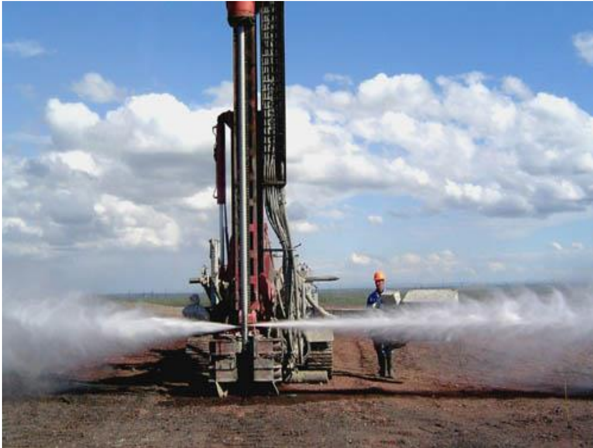
Рис. 60. Установа для струменевої цементації ґрунтів
