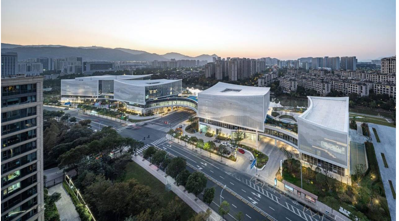
Рис. 2.6.1 Загальний вигляд будівлі High-tech Cultural Square [17]
