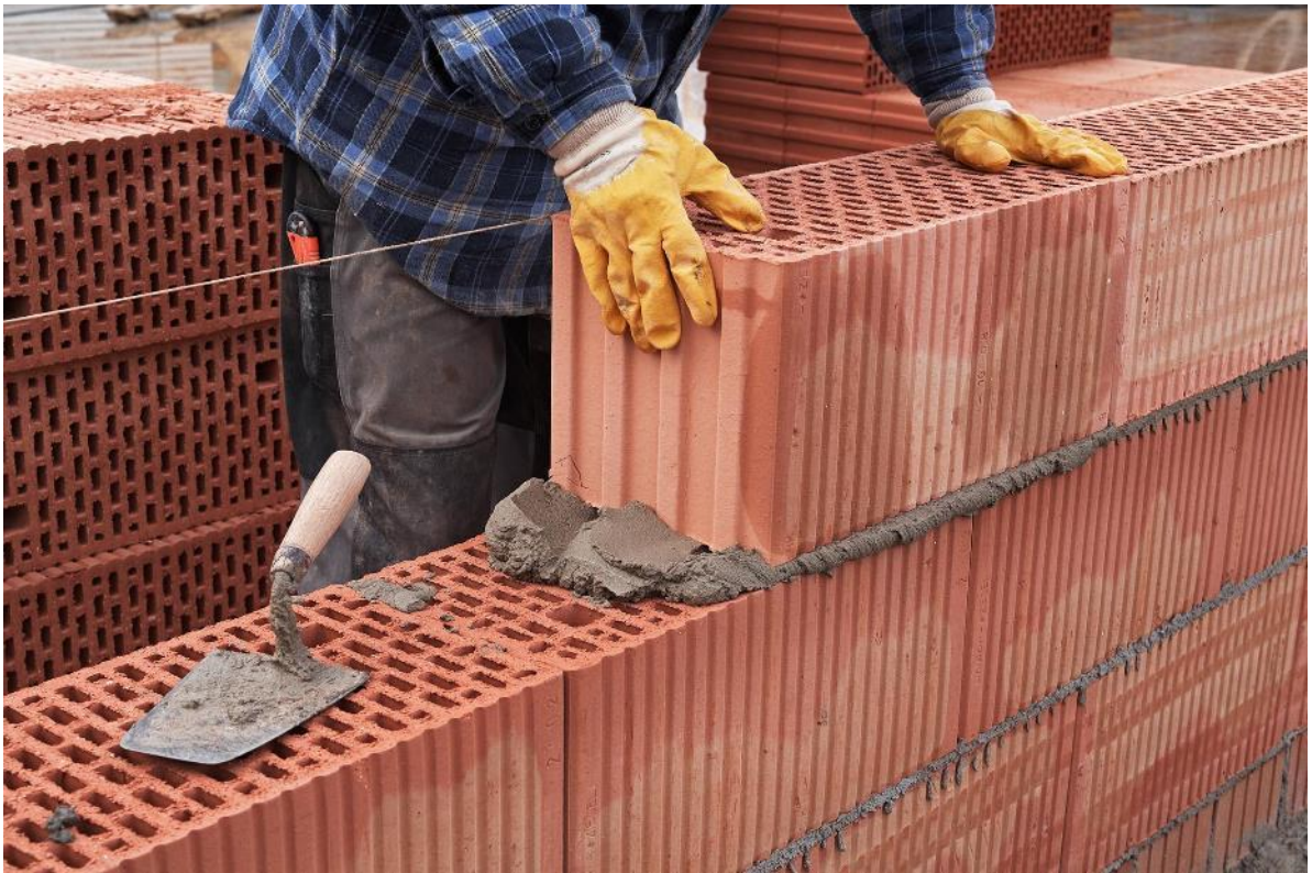
Рис. 6.2.1. Кладка керамічних блоків [11]
