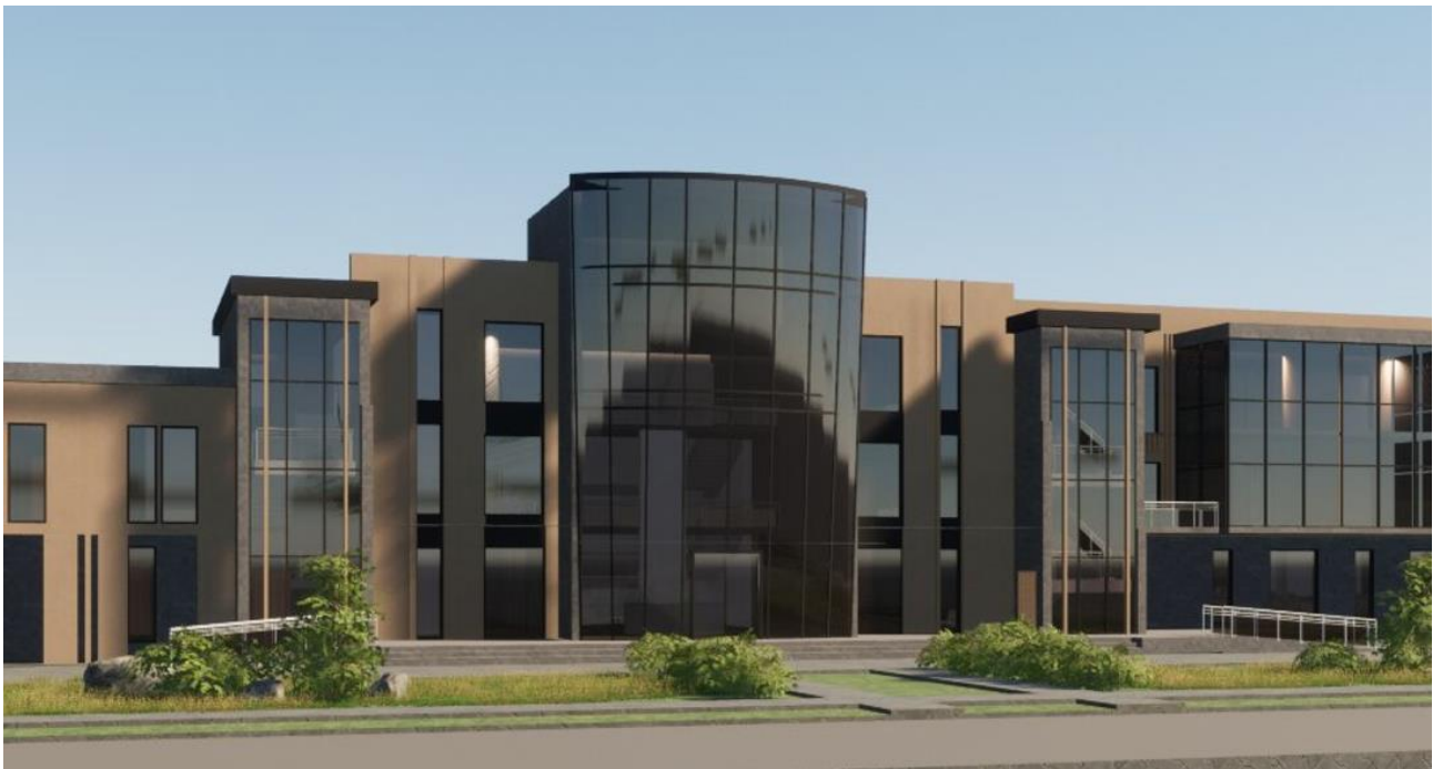
Рис. 6.7.1. Вітражна алюмінієва конструкція на фасаді
