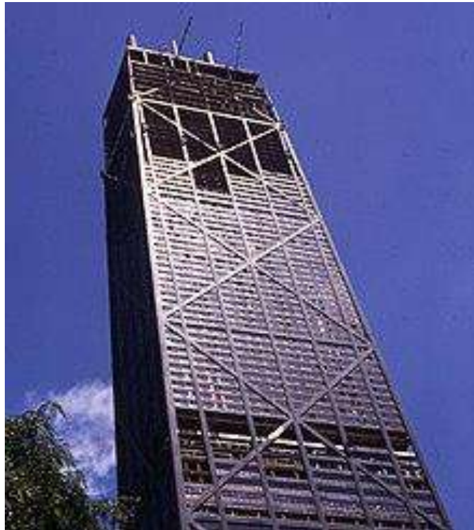
Рис. 4.8. Фото 17 серпня 1968 року під час будівництва [124].
