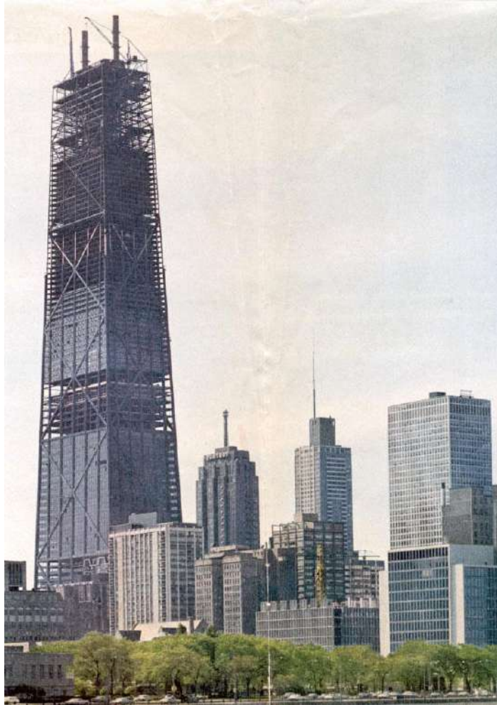
Рис. 4.9. Фотографія Центру Джона Хенкока під час будівництва [126].
