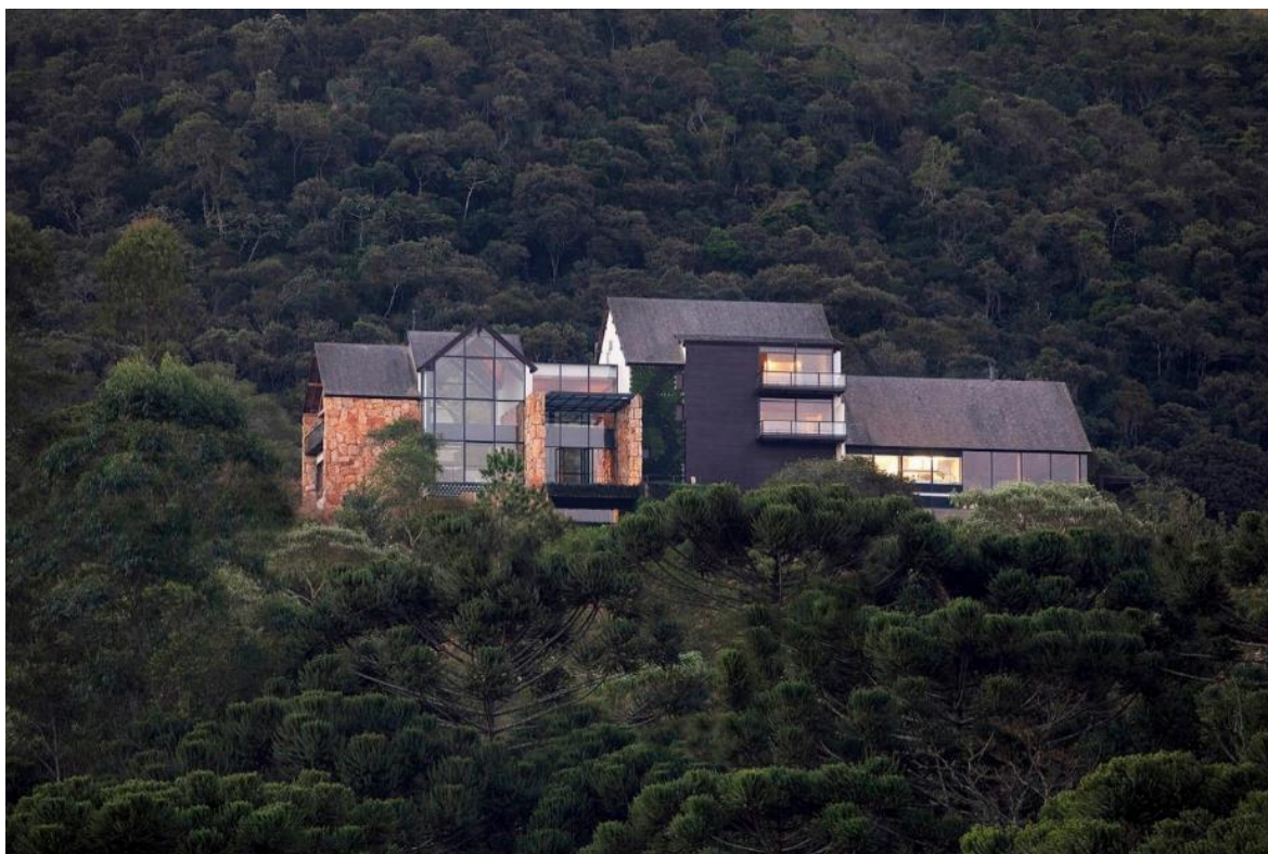
Рис. 2.5 Загальний вид на готель
