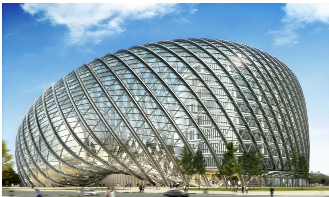
Рис. 2.4.1. Фасад Phoenix International Media Centre [27]
