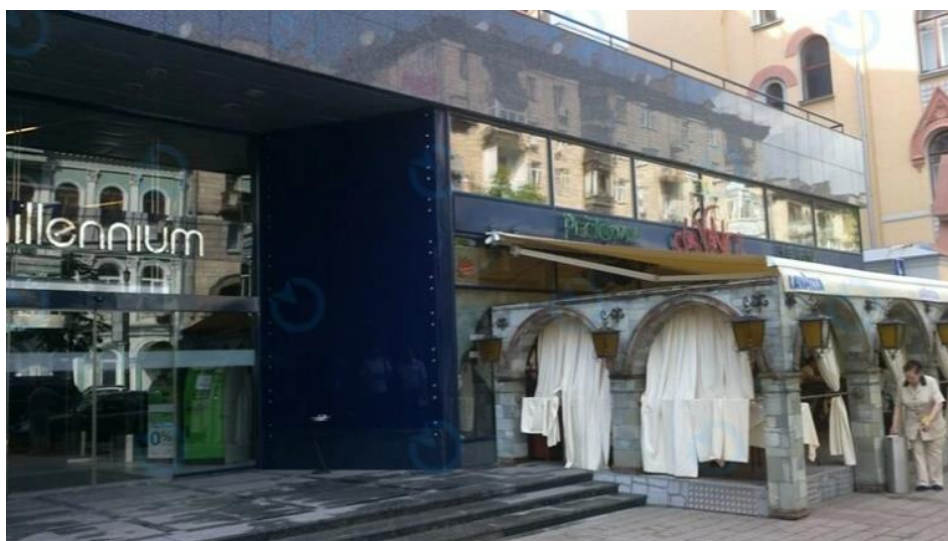
Рис.2.3 Фото з вулиці на головний вхід у бізнес-центр [26]
