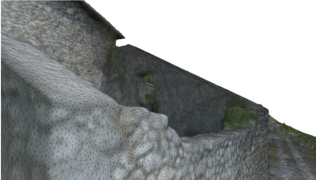
Рис1.3.1 Приклад стіни, знятої фотограмметрією з надто низькою роздільною здатністю, здається пом'якшеним.
