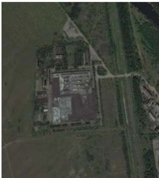
Рис.3.2. Горлівські фільтрувальні станції № 1, 2 КП «Компанія «Вода Донбасу»
