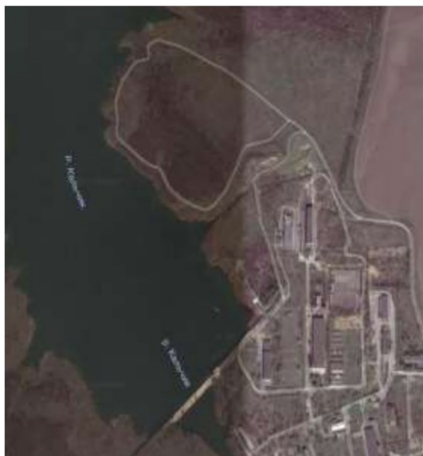
Рис.3.1. Старокримські фільтрувальні станції № 1, 2 КП «Компанія «Вода Донбасу»
