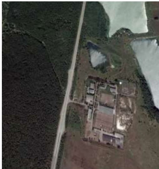
Рис.3.3. Донецька фільтрувальна станція КП «Компанія «Вода Донбасу»
