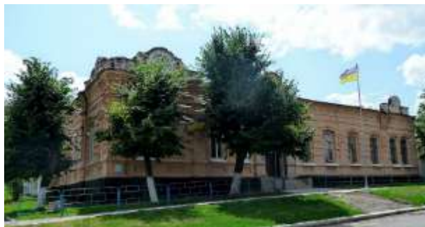
Рис. 3.1.12.2.3.7. Будинок за адресою: Вул. Старопоштова, 37. Військкомат [25].
