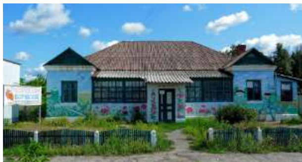
Рис. 3.1.12.2.3.16. Будинок за адресою: Вул. Івана Мазепи, 36. Ізюмський вернисаж [25].
