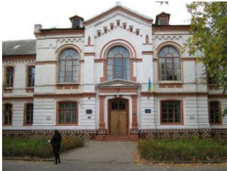
Рис. 3.1.12.3.6. Реальне училище (нині ЗОШ № 4), побудоване в 1882 році [24]
