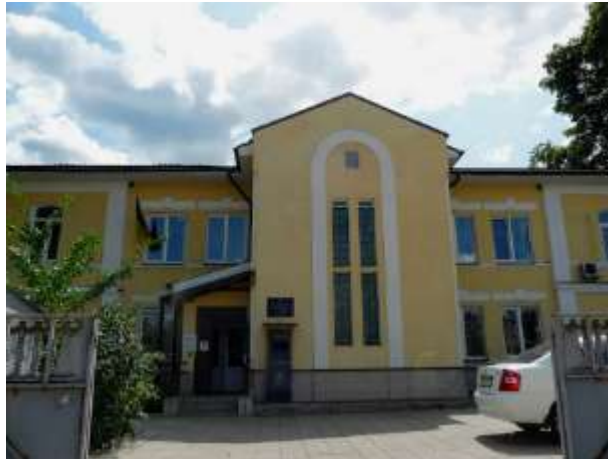
Рис. 3.1.12.2.3.9. Будинок за адресою: Вул. Соборна, 56. Центр зайнятості (колишня унтер-офіцерська школа) [25].
