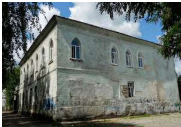
Рис. 3.1.12.2.3.12. Будинок за адресою: Площа Джона Леннона, 8. Будинок культури [25].
