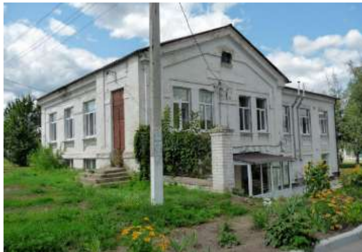
Рис. 3.1.12.2.3.4. Будівля дитячої поліклініки [25].
