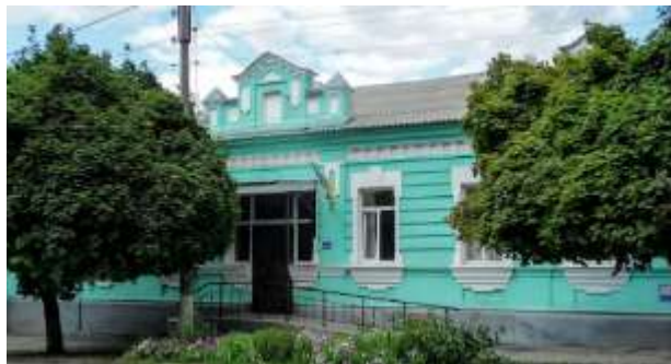
Рис. 3.1.12.2.3.2. Будинок за адресою: Вул. Покровська, 57 (колишній Народний дім) [25].
