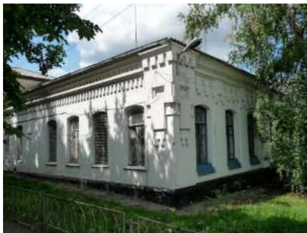
Рис. 3.1.12.2.3.10. Будинок за адресою: Вул. Старопоштова, 39. Відділення поліції [25].
