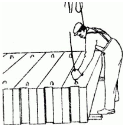
Рис. 11. «Стропування блоків»
