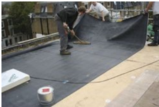
Укладання рулонного полотна
