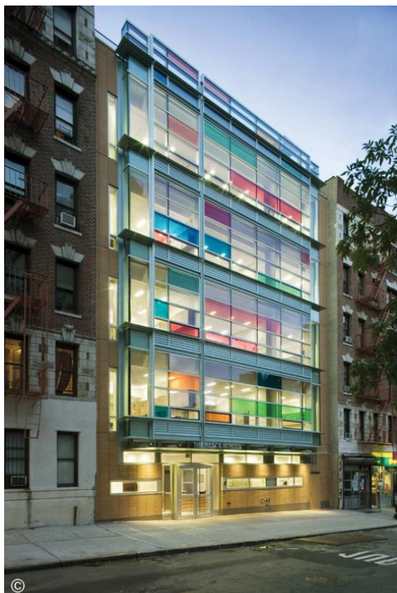
Фото будівлі ззовні (рис. 2.5) [2].
