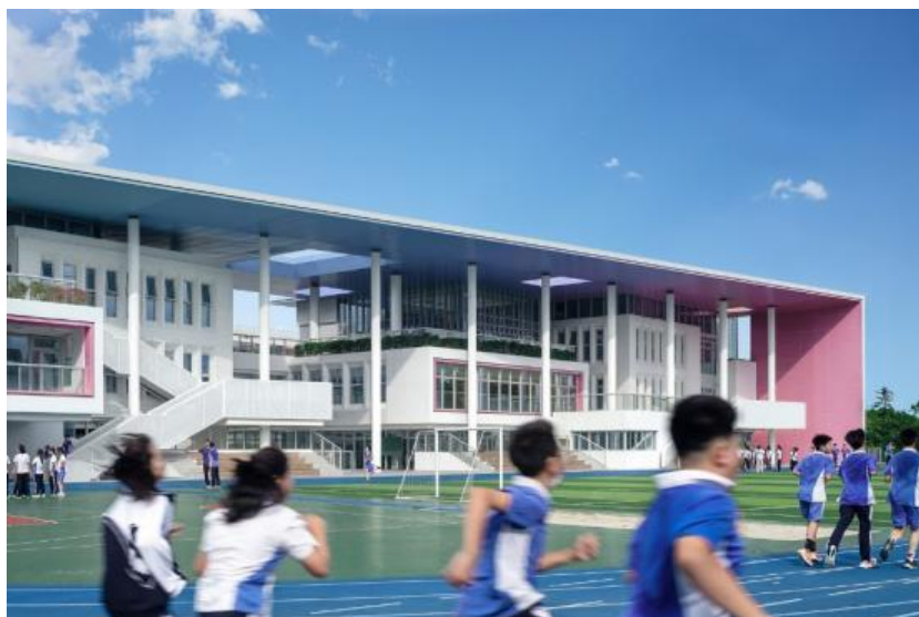
Рис. 2.3.3 Загальний вигляд фасаду спортивного блоку Campus of Shenzhen Senior High School Group [6]
