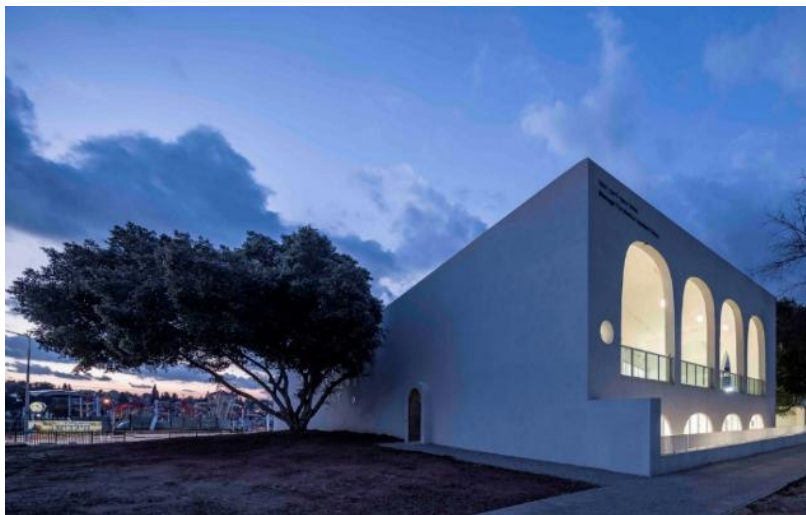
Рис. 2.2, «Ezra Lemarpe Medical Rehabilitation Center» [2]
