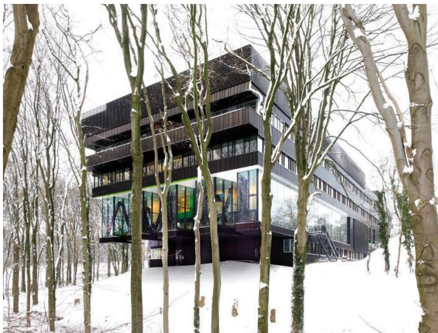
Рис. 2.1, «Rehabilitation Centre Groot Klimmendaal» [1]
