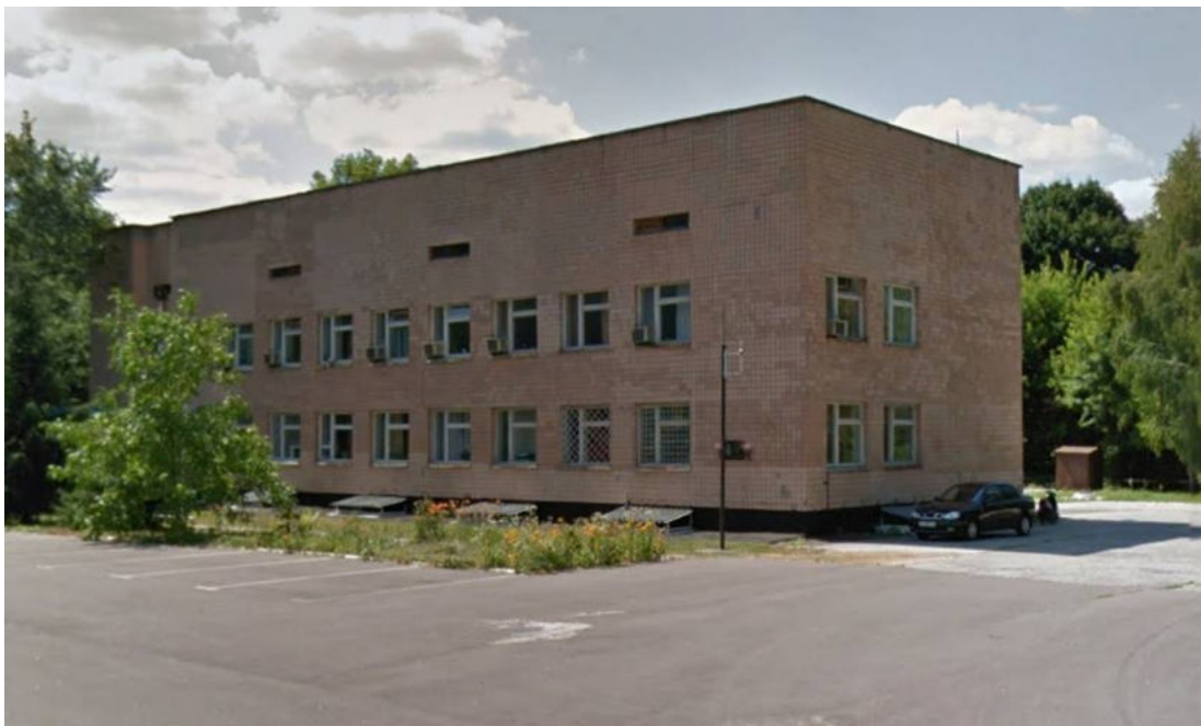
Рис.3.1.9. Будівля Центру організаційно-технічного і інформаційного забезпечення управління Зоною відчуження [52]
