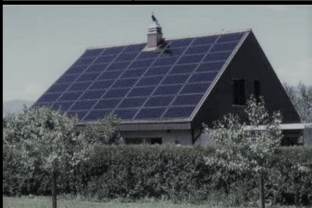
Будинок с сонячною ел.-панелями.
