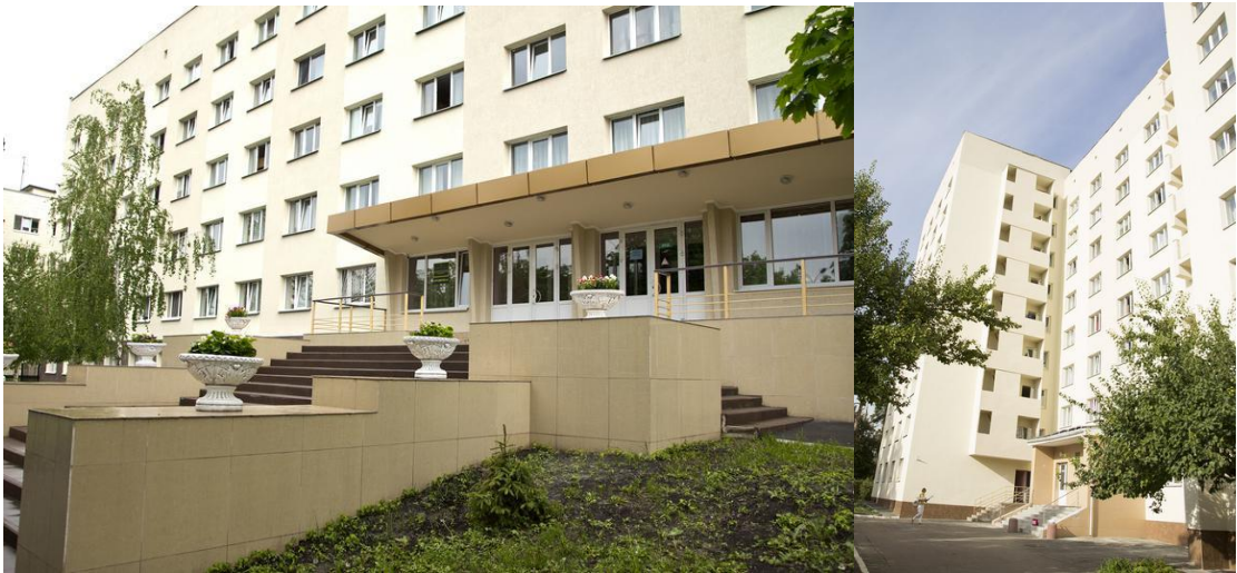
Рис. 1.33. Гуртожитки ДТЕУ. Загальний вигляд [32]
