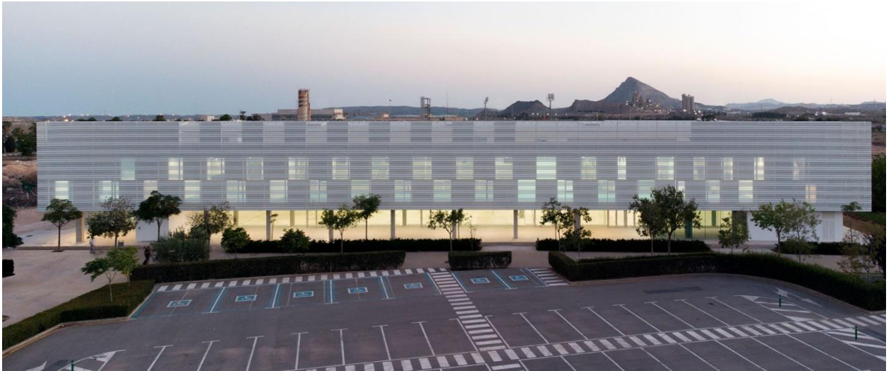
Рис. 2.1 Головний фасад будівлі
