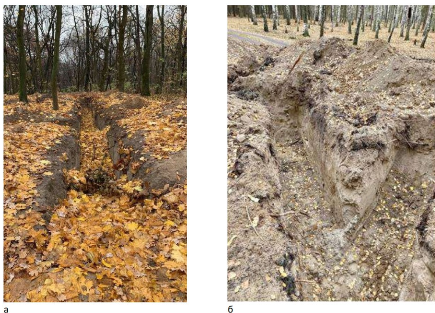
Рис.2.4. Приповерхневі фортифікаційні споруди – траншеї : а) поблизу м. Київ; б) поблизу м. Тростянець Сумської області (Фото з мережі інтернет, автор Анастасія Сплодитель)
