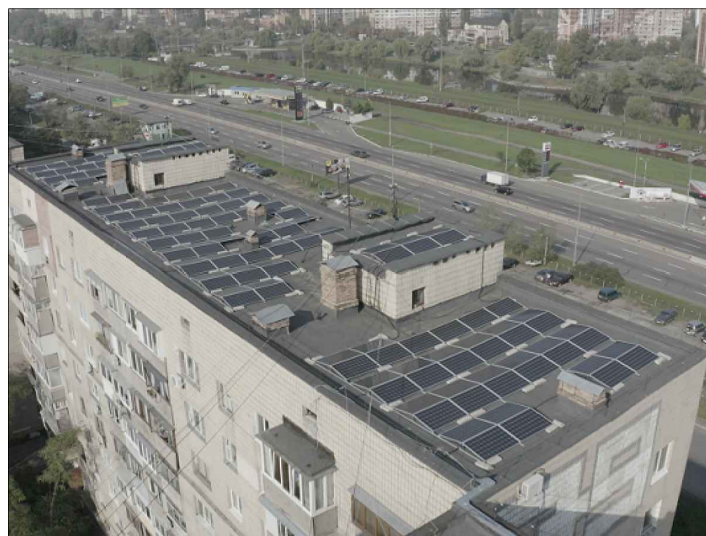
Сонячні батареї на даху будівлі
