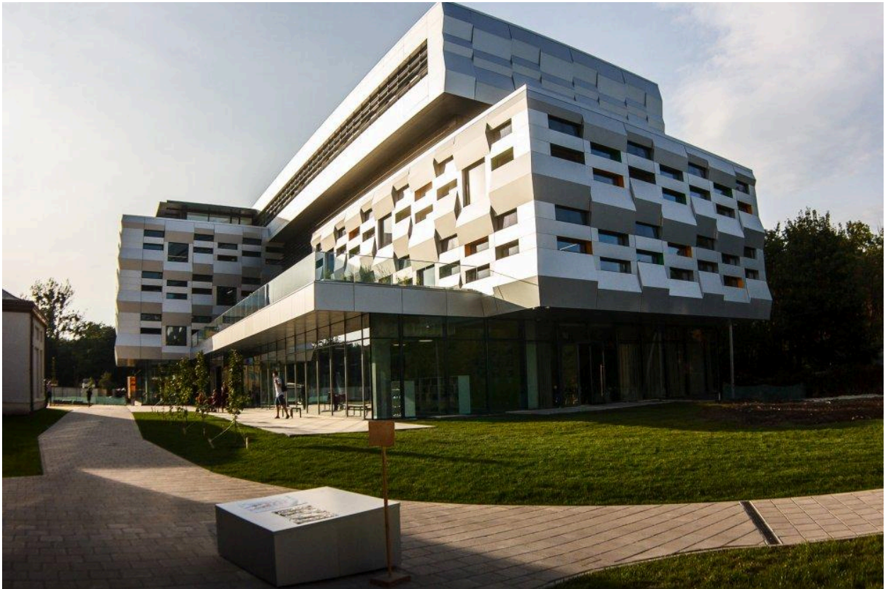
Рис.4.6. Центр митрополита Андрія Шептицького Українського католицького університету у Львові — приклад інклюзивного освітнього центру [92]
