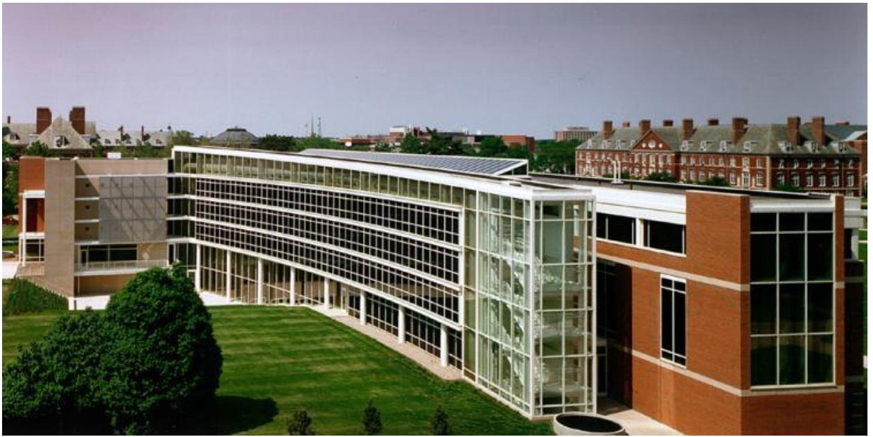
Рис.9. Архітектурний коледж в університеті Іллінойсу
