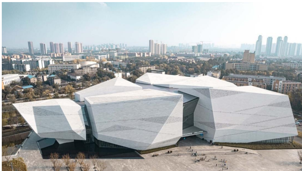
Рис. 2.1. Загальний вигляд будівлі [13]
