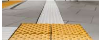
Рисунок 1. Тактильні тротуарні плитки
