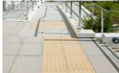
Рисунок 2. Тактильні тротуарні плитки зовні приміщення
