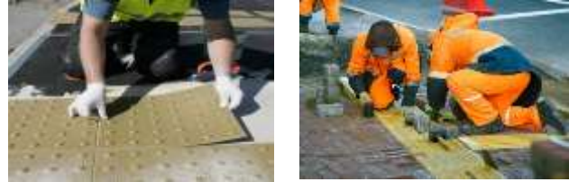
Рисунок 3. Використання склопластику для тактильного покриття
