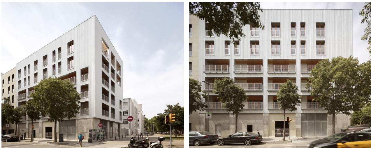
Рис. 2.14 Загальний вигляд La Balma Collective Housing [19]
