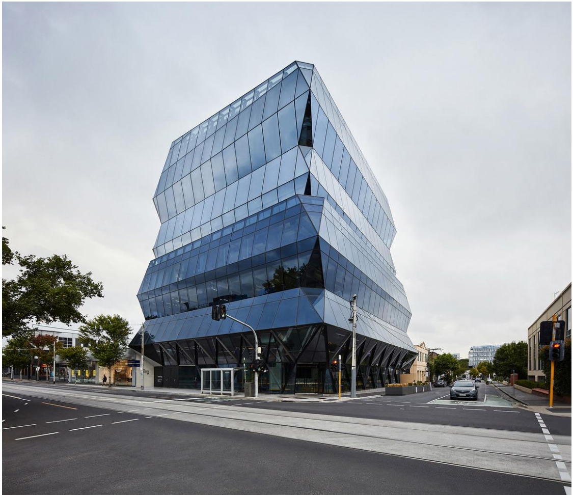
Рис. 2.13. Загальний вигляд будівлі [4]
