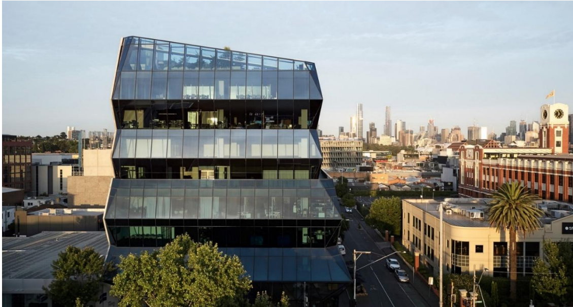
Рис. 2.14. Будівля та навколишнє середовище [4]
