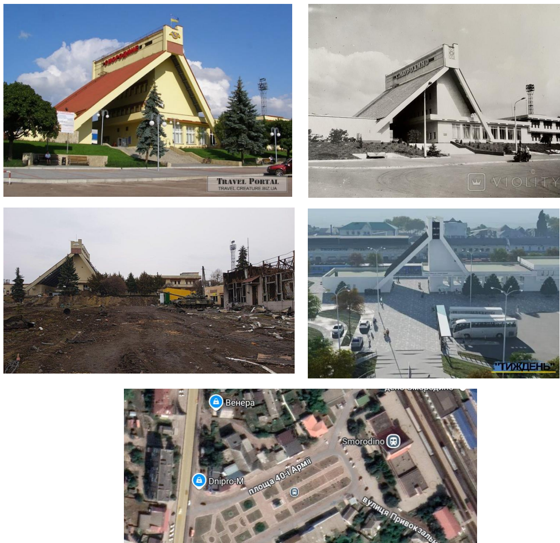
Рис. 1.7. Вокзал станції Тростянець-Смородине
