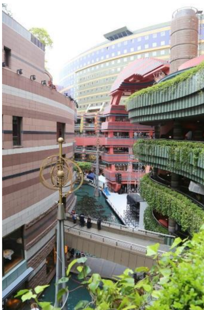
Рис. 2.8 Загальний вид на Canal City
