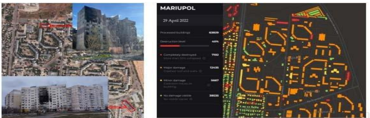
Рис. 3.3. Руйнування та пошкодження великопанельних будинків Східного району м. Маріуполя Донецької області
