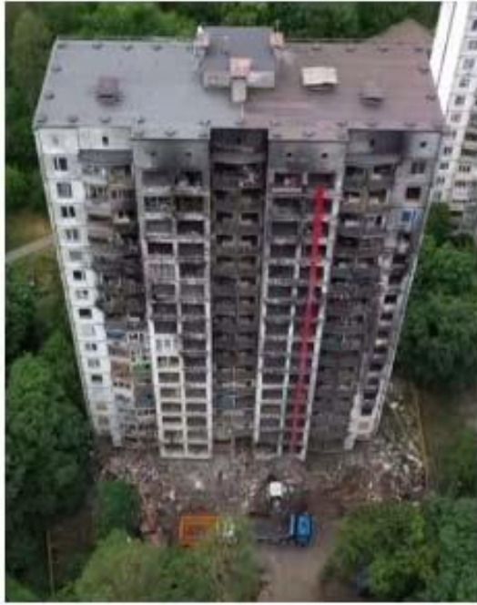
Рис. 3.4. Пошкодження багатоквартирного великопанельного будинку серії БПС по вулиці Чорнобильській, м. Київ
