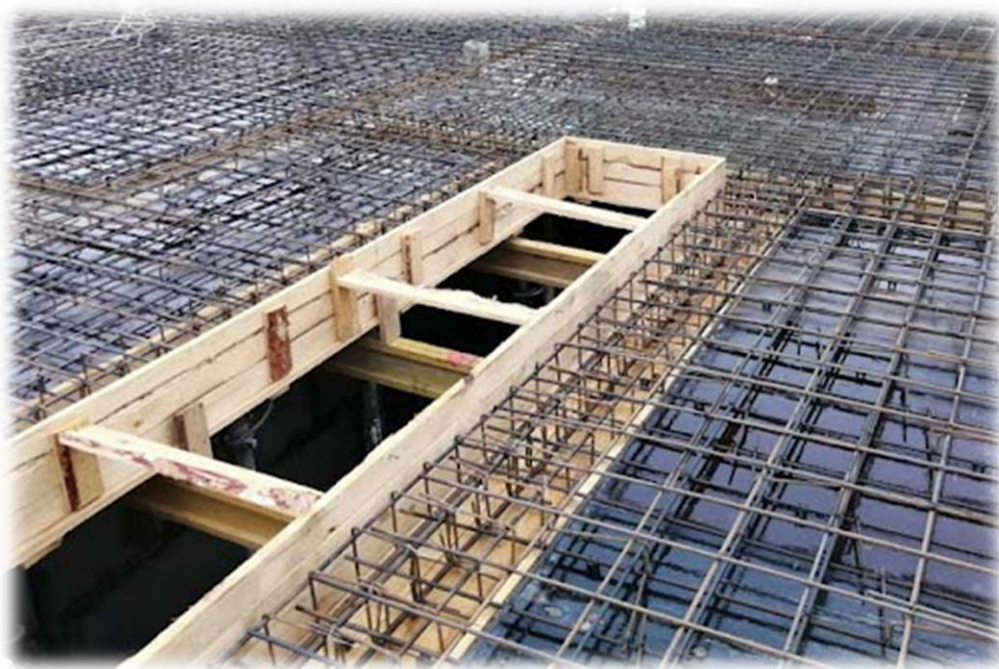
Рис. 4.1 Монолітна плита перекриття
