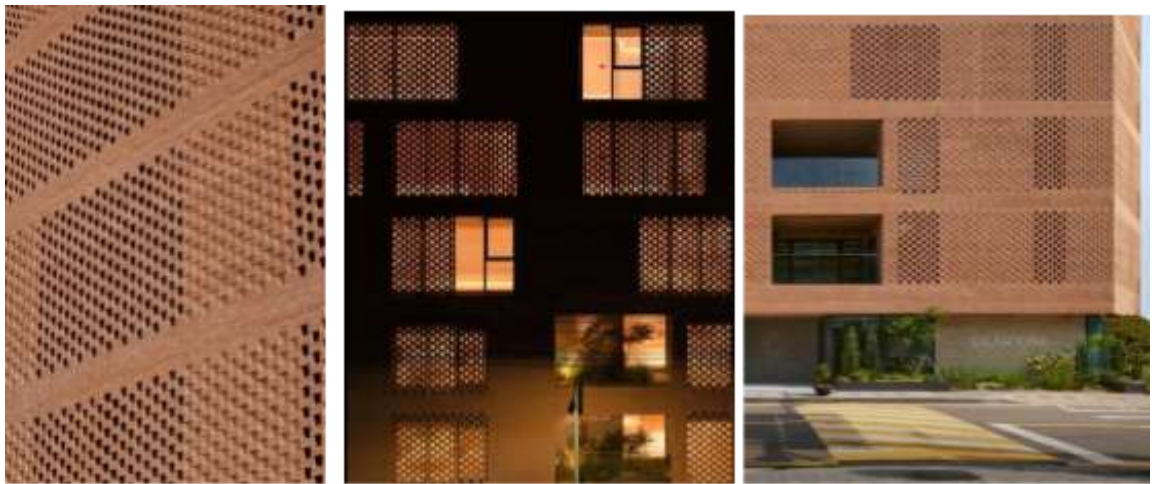
Рис.2.4.4. Оздоблення фасадів перфорованою сіткою [12]
