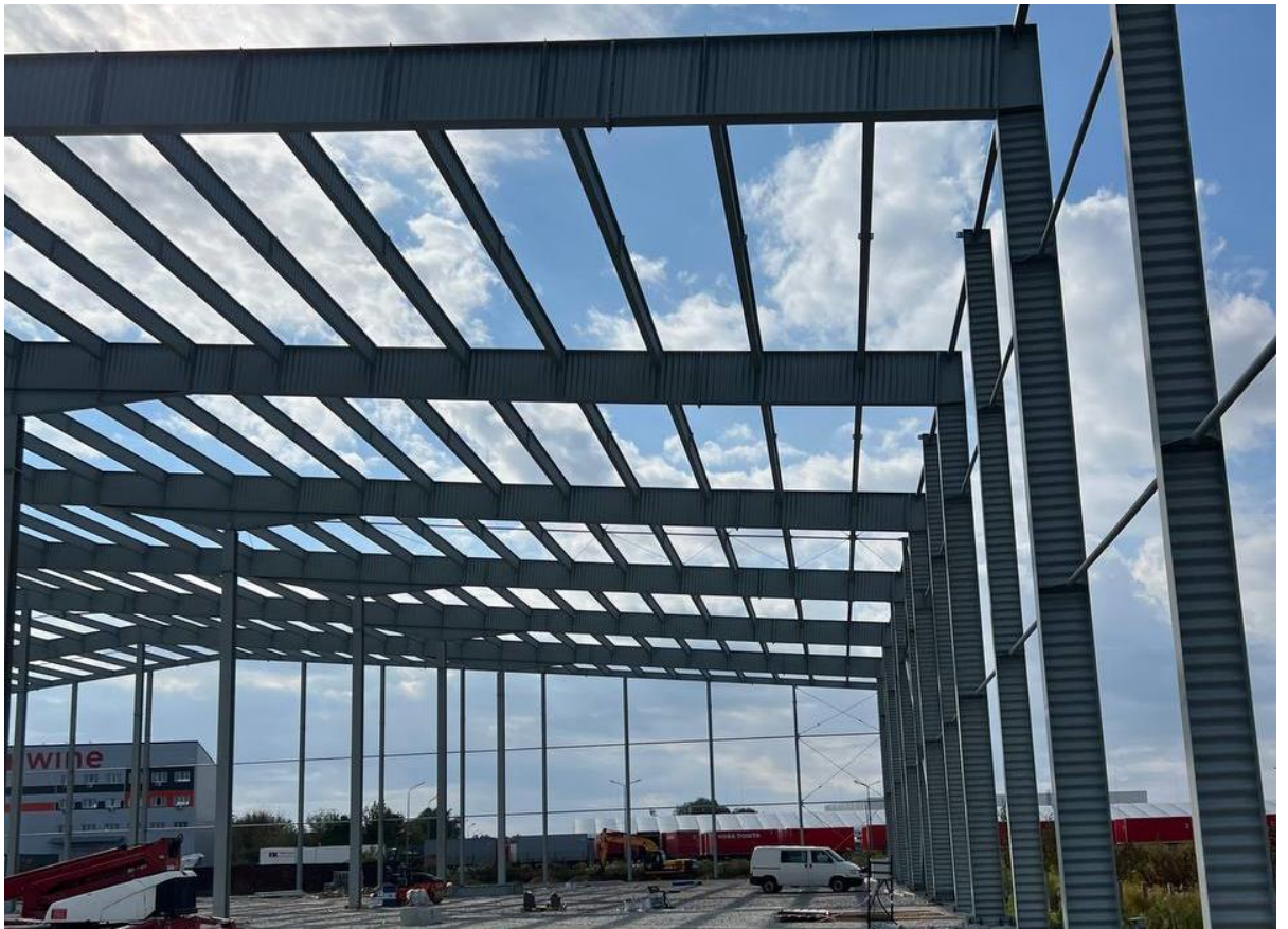
Рис. 1.1.4 Каркас складського приміщення
