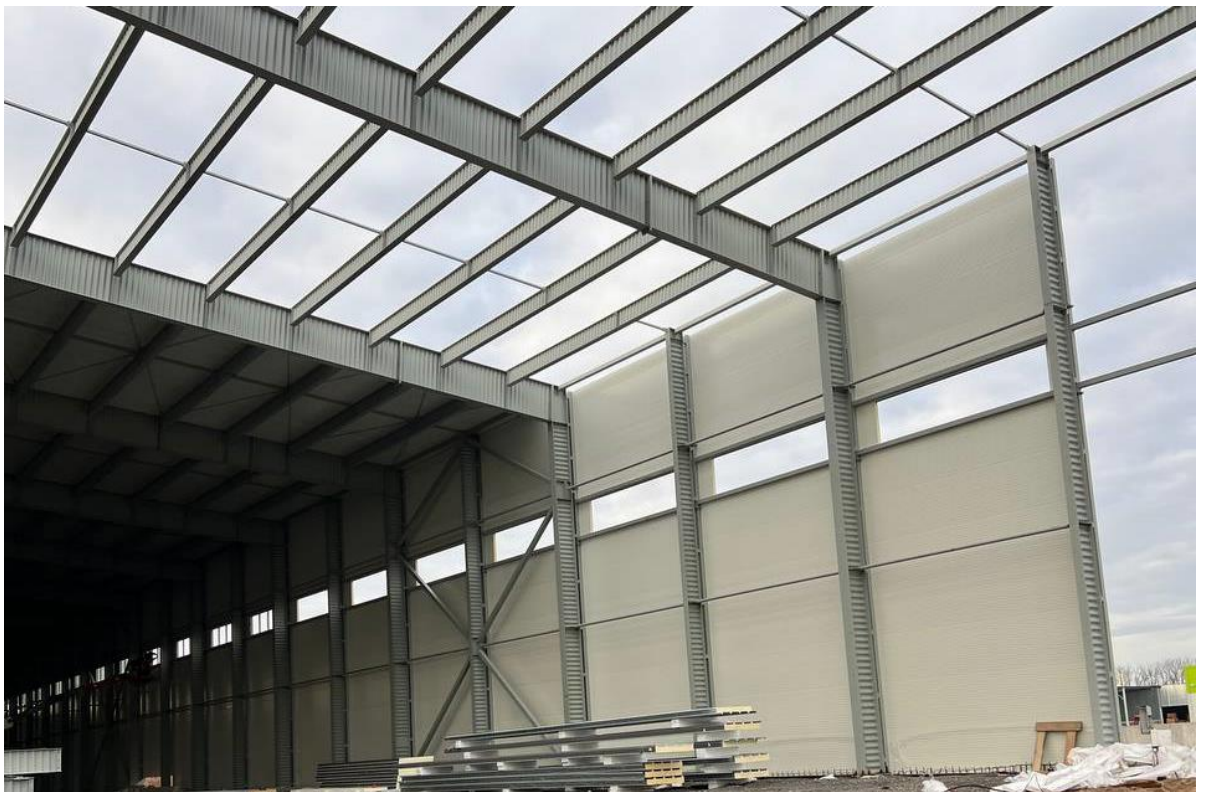
Рис. 1.1.5 Обшиття стін сендвіч-панелями
