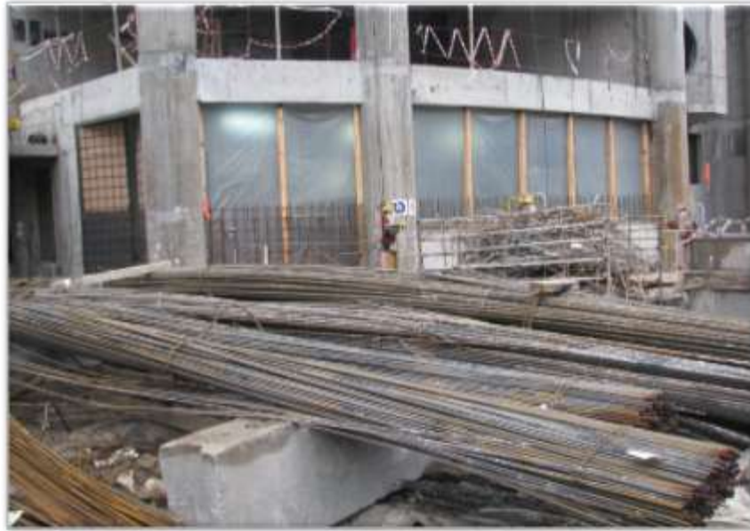
Рис. 11. Складування арматурних канатів
