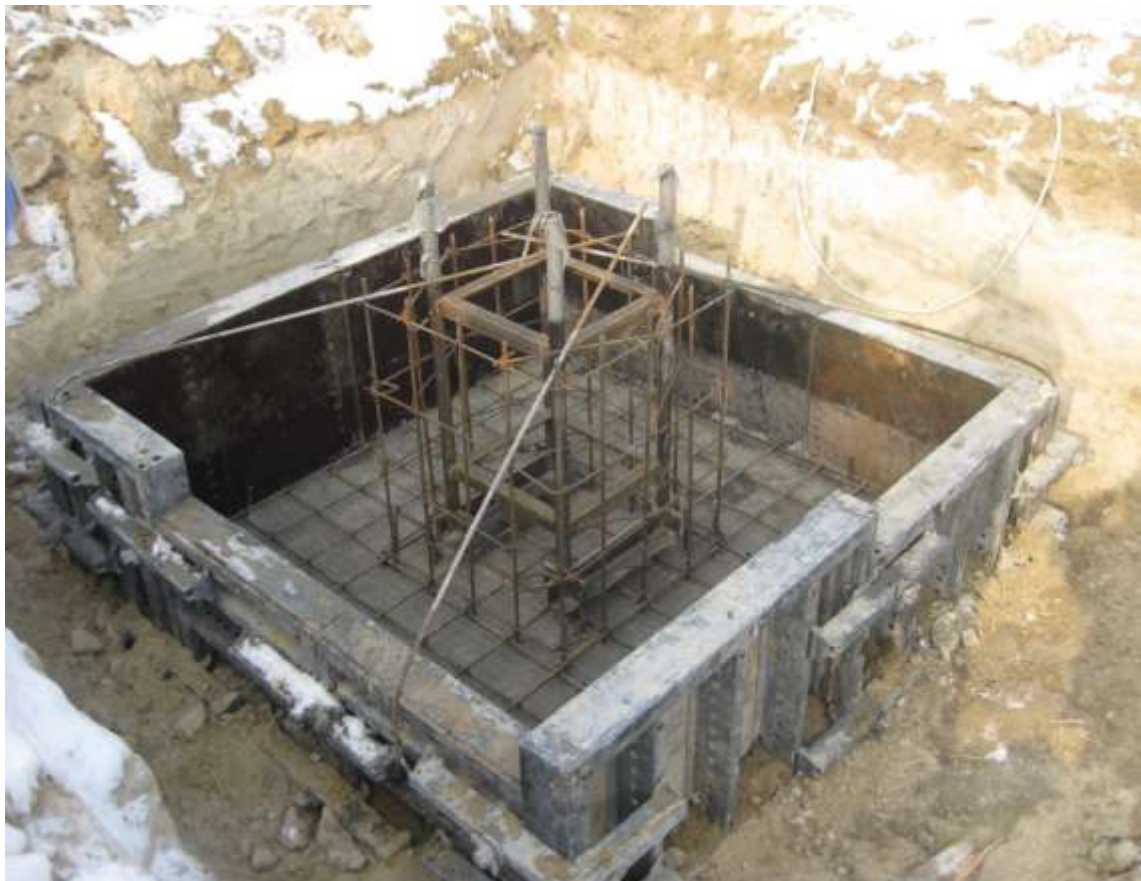
Рис. 13. Армування монолітних фундаментів
