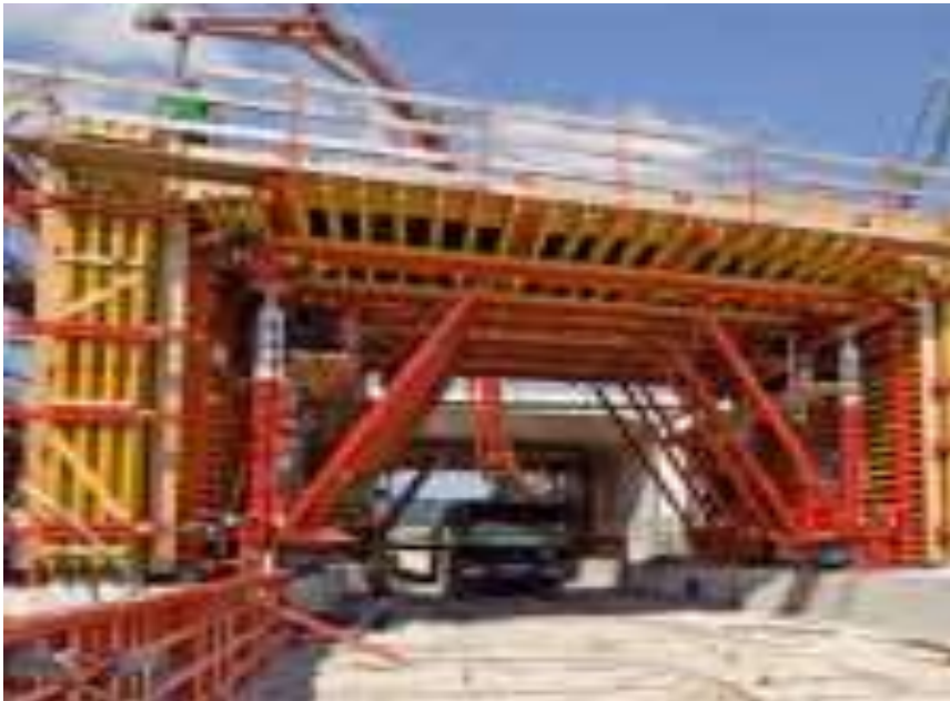
Рис. 4. Ковзна опалубка
