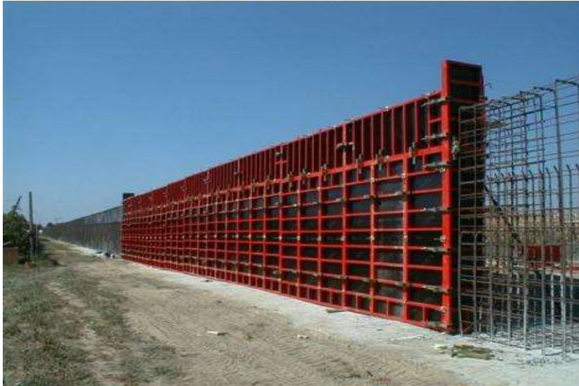
Рис. 7. Горизонтально перемішувана опалубка
