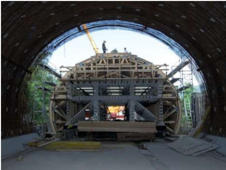
Рис. 5. Горизонтально переміщувана опалубка
