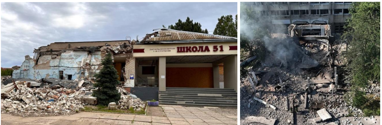
Руйнування ліцею №51 (зліва) та головного корпусу НУК (справа)
