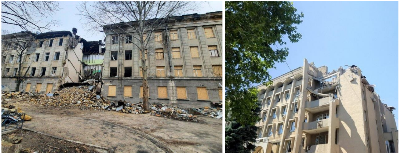
Руйнування політехнічного коледжу (зліва) та університету (справа)
