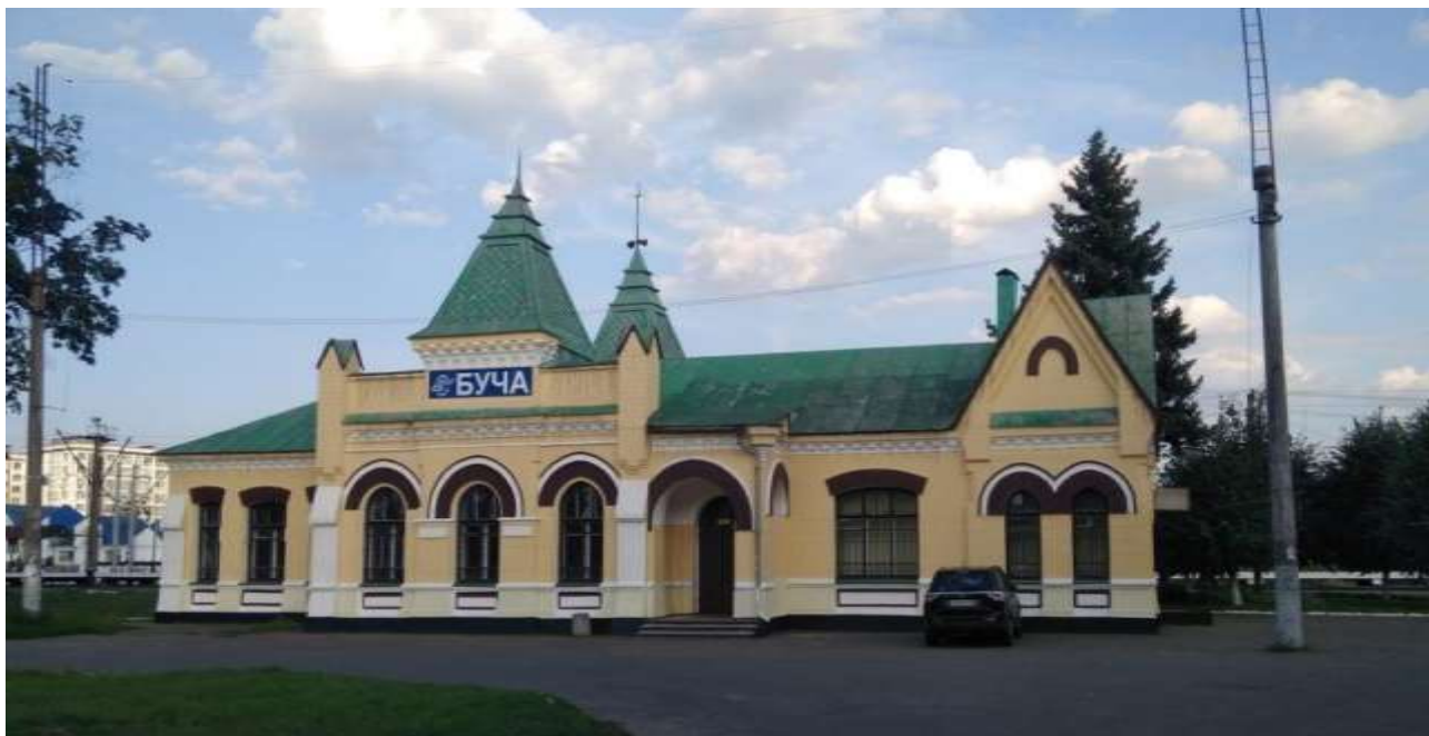
Рис. 3.1 Залізнична станція Буча [6]
