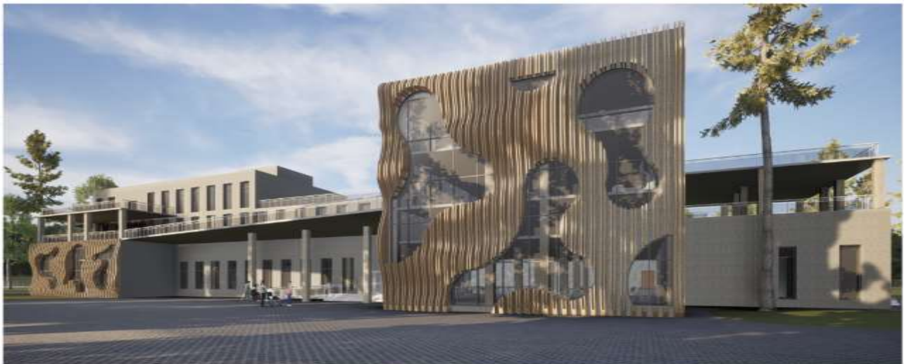
Рис. 4.1 Загальний вид на будівлю
