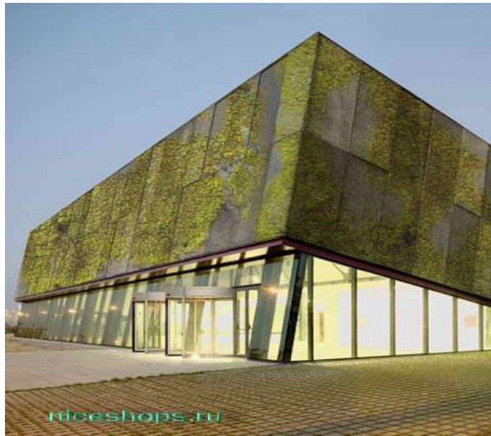
Рис. 1.2.14. Будівля Політехнічного інституту в Барселоні з новою технологією розміщення рослин на фасаді - за допомогою органічного бетону, що поглинає вологу [48]
