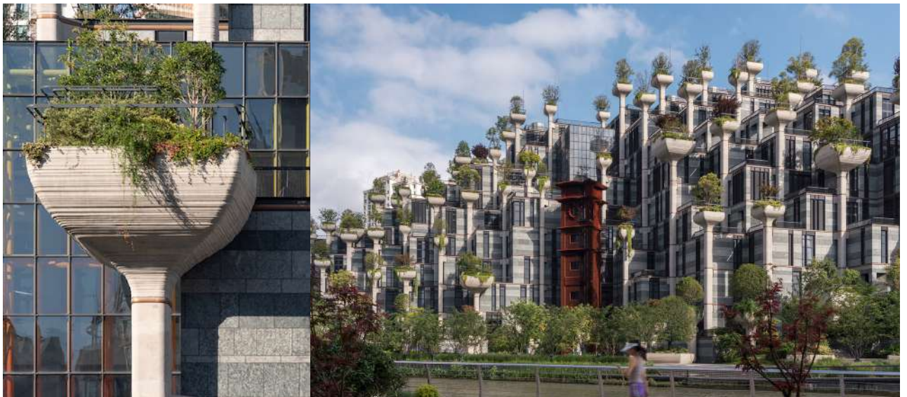
Рис.1.2.15. Комплекс в Шанхаї від архітектора Томаса Хезервіка, де для рослин спроектовано спеціальні стовпи-колони [48]
