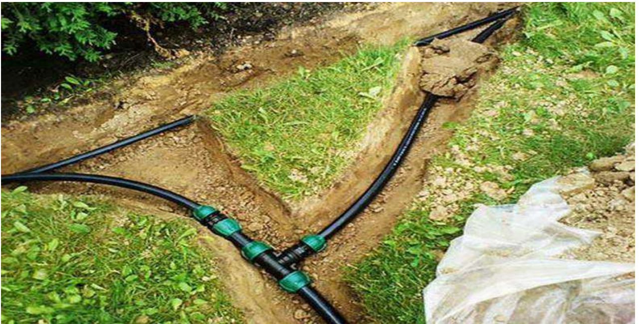
Рис. 2.2.10. Внутрішньогрунтова система поливу [64]
