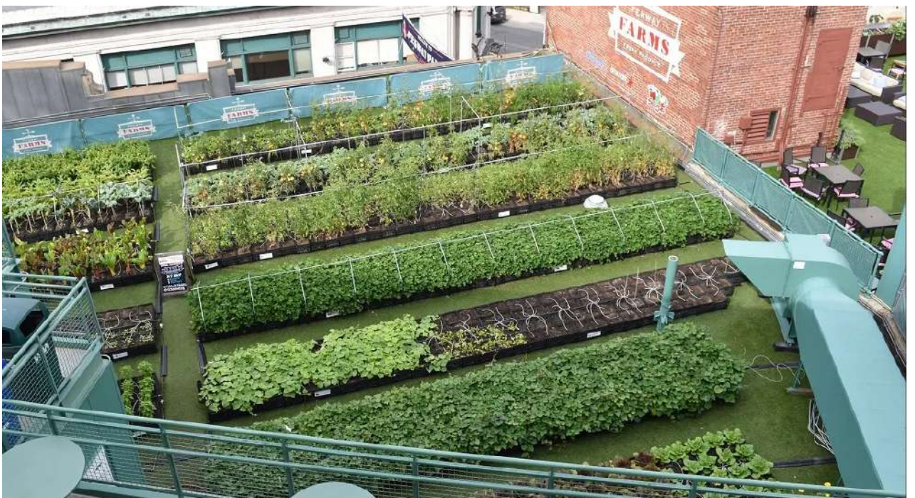
Рис. 2.1.3. Приклад влаштування саду та городу на даху житлового будинку [66]
