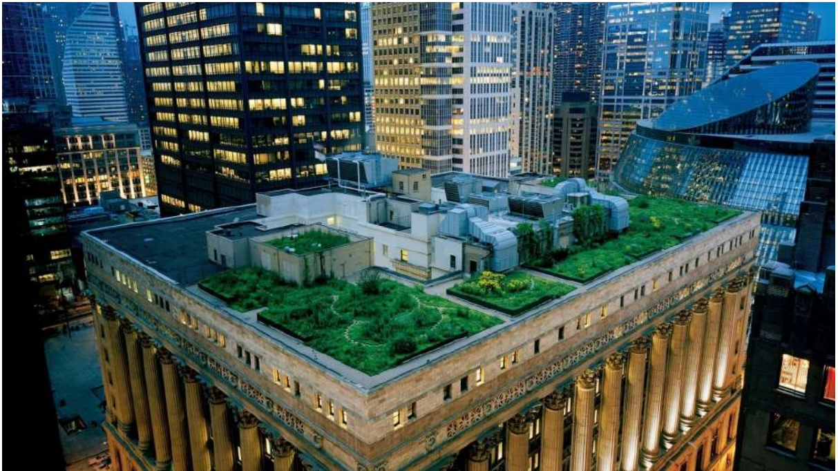
Рис. 1.2.9. Сад на будівлі City Hall в Чикаго від Conservation Design Forum і Atelier Dreiseitl [49]
