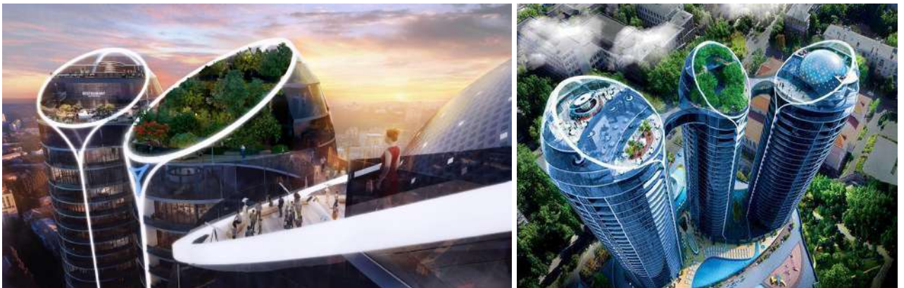
Рис. 1.3.14. Taryan Towers в Києві [56]
