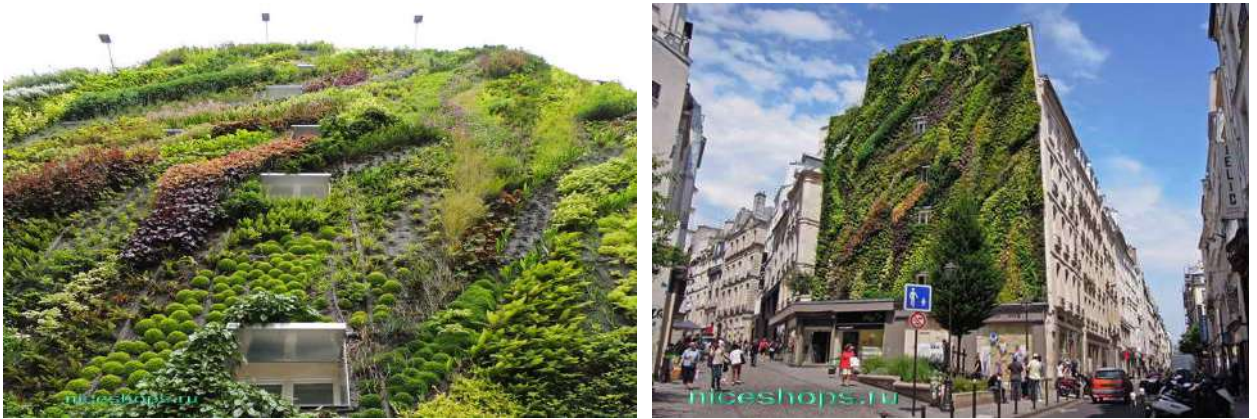
Рис. 1.2.7. Озеленення фасаду житлового будинку в Парижі [48]
