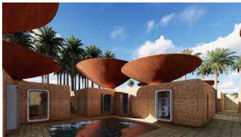
Рис. 2.1.2. Розміщення ковша для збору дощової води на даху будинку [50]
