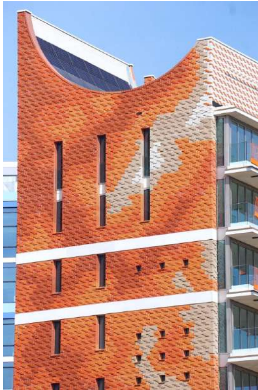
Рис. 2.1.1. Ковш для збору води як архітектурний елемент в The George Residential Building (пункт 1.3) [50]
