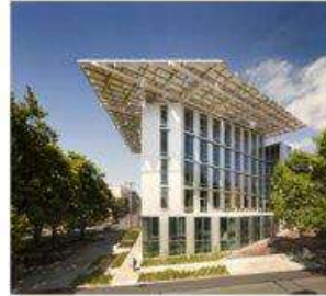
BULLIT CENTER/MILLER HULL/USA/2013 р./
