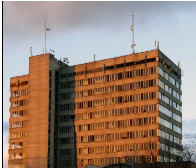
Рис. 3.4 Адміністративна будівля колишнього заводу “Іскра” [6]
