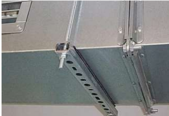
Рис. 5.2. Монтаж на шпильку та траверсу
