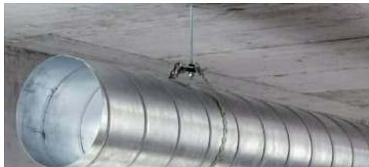
Рис. 5.4. Монтаж на перфоровану стрічку
