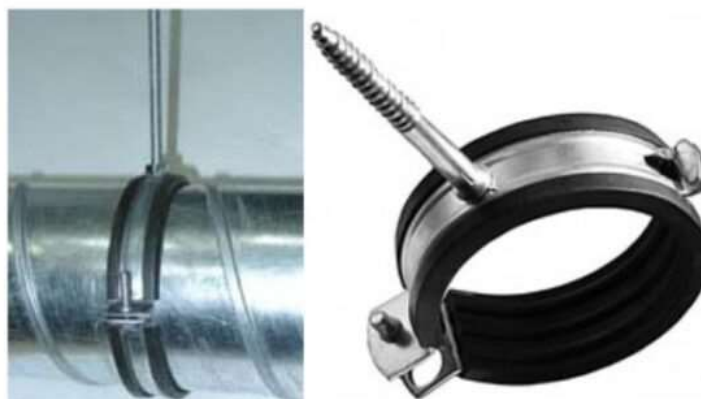
Рис. 5.3. Монтаж на шпильку та хомут
