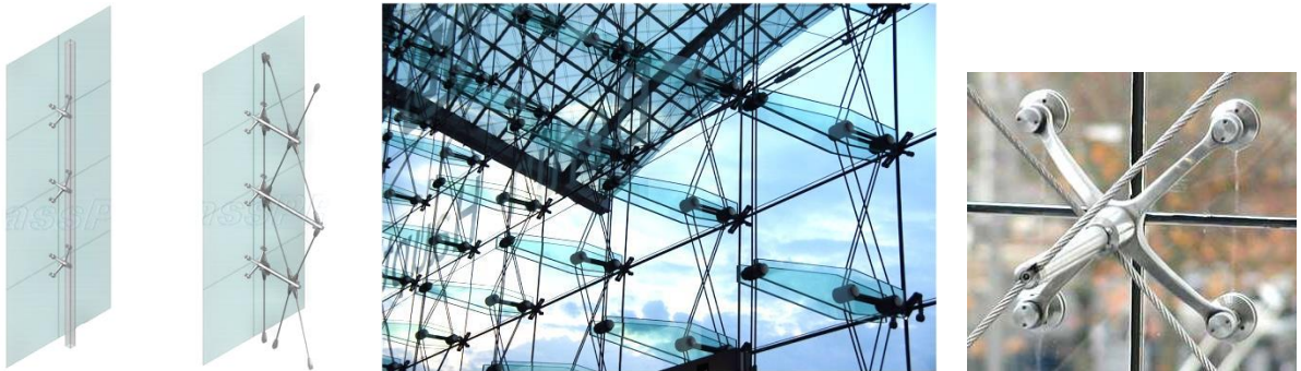
Конструктивні вузли структурного та спайдерного скління
