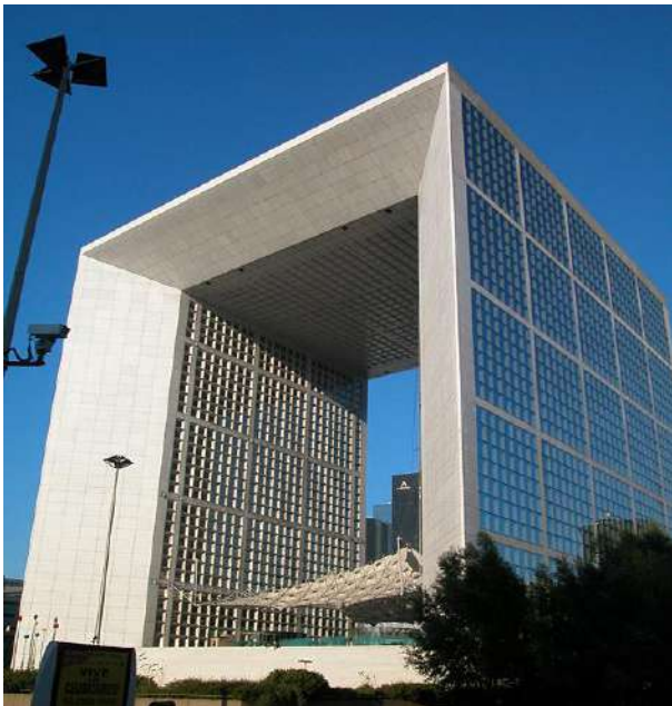
La grande arche de la Defense, Paris, architect Johann Otto von Spreckelsen, 1989
