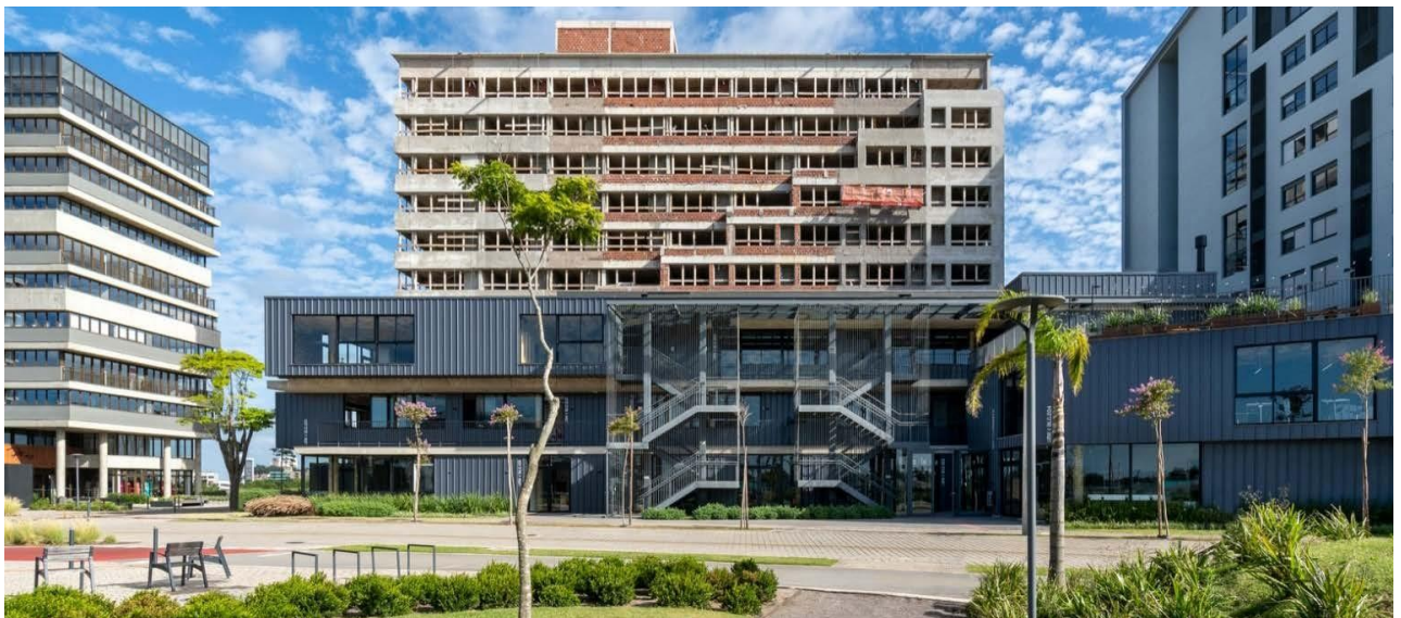
Рис.2.1. Фасад офісного центру Una Makers
