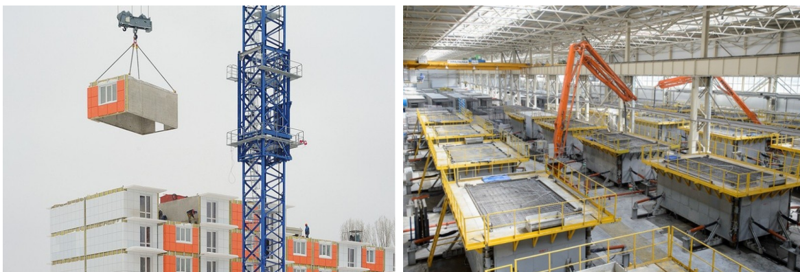
Рис. 1.20. Об'ємноблокова будівельна система: а – монтування об'ємних блоків на будівельному майданчику; б – виготовлення об'ємних блоків на заводі
