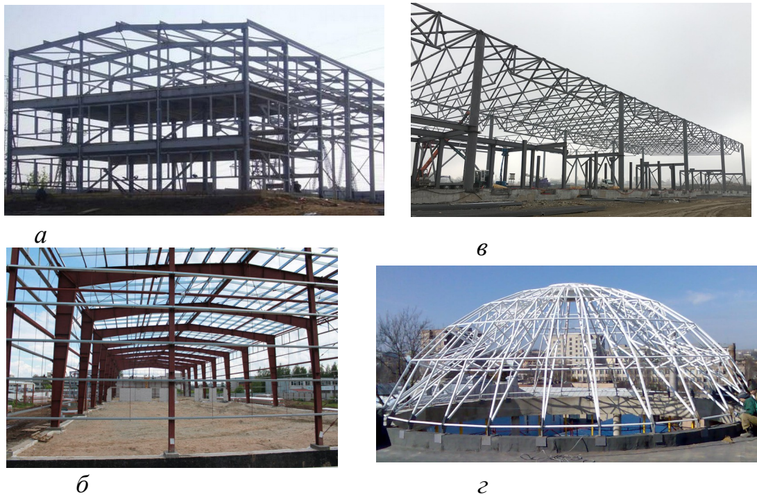
Рис. 1.26. Каркасно-панельні будівлі зі сталевими несучими конструкціями покриттів:
