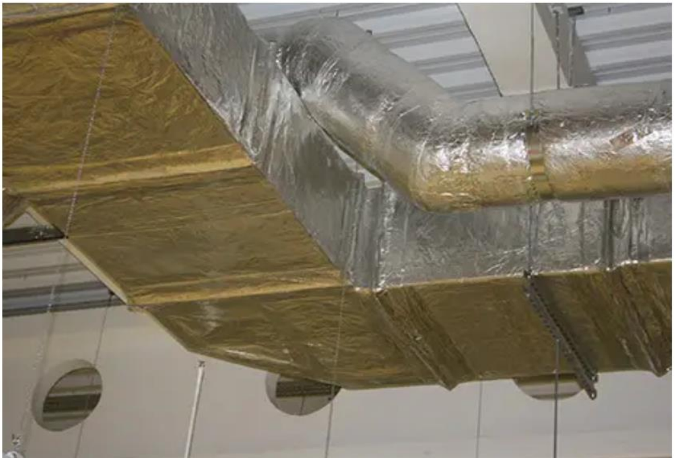
Рис.12 Приклад виконаного монтажу повітроводів у вогнестійкої ізоляції типу «FIX-M»
