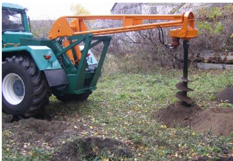
Рис. 1.1 Навісне бурильне обладнання марки БКМ–2М на Т-150
