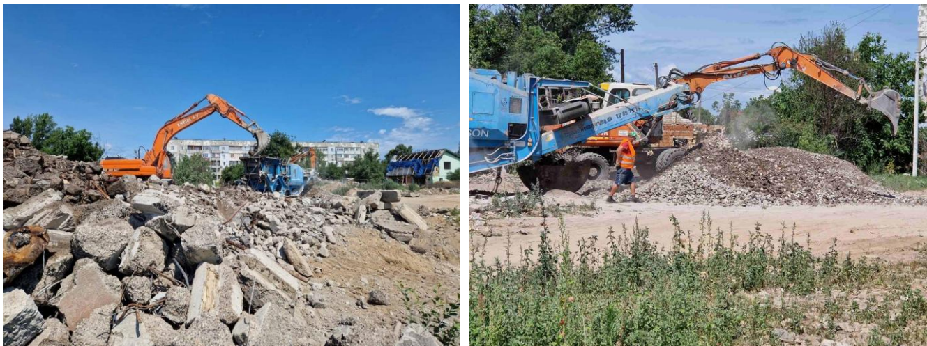
Рис. 1. Попередня переробка будівельних матеріалів пошкоджених будівель:
