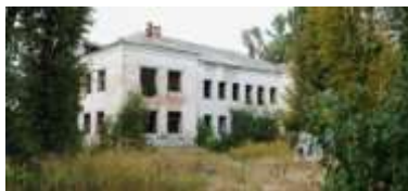
Рисунок 1. Будівля колишнього дитсадка
