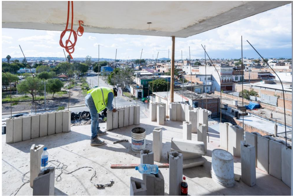
Рис. 2.4.4. Встановлення унікальних збірних бетонних блоків [5]
