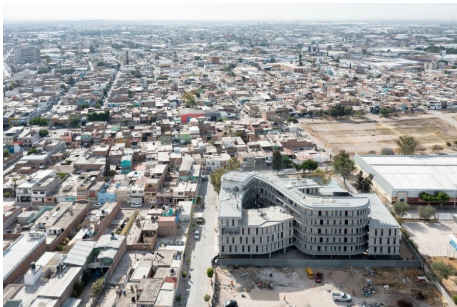
Рис. 2.4.1. Вигляд ситуації навколо будівлі [5]
