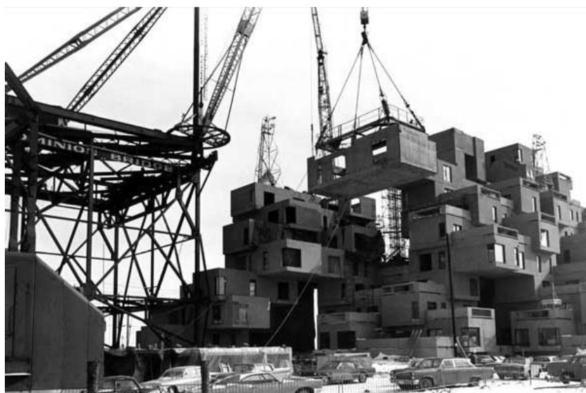
Рис. 2.1.4. Встановлювання житлових чарунок [2]
